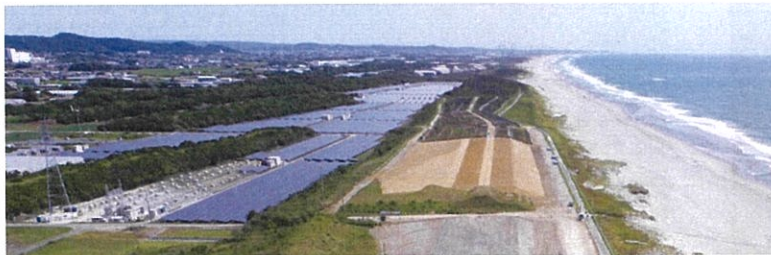
市内最大の掛川大淵・沖之須太陽光発電所
