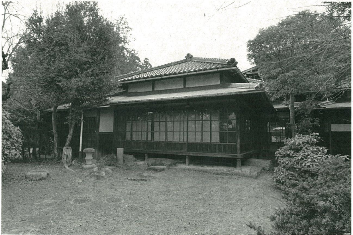
6. 旧山崎家住宅新座敷（西より）
