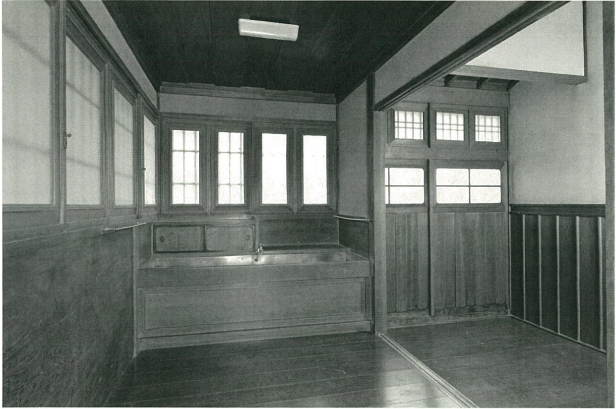
10. 旧山崎家住宅風呂・洗面内観（東より）
