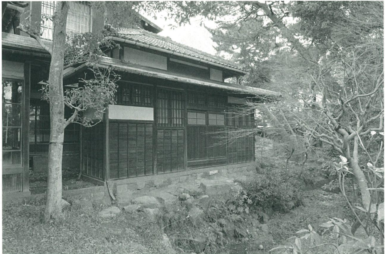
9. 旧山崎家住宅風呂・便所棟（北西より）
