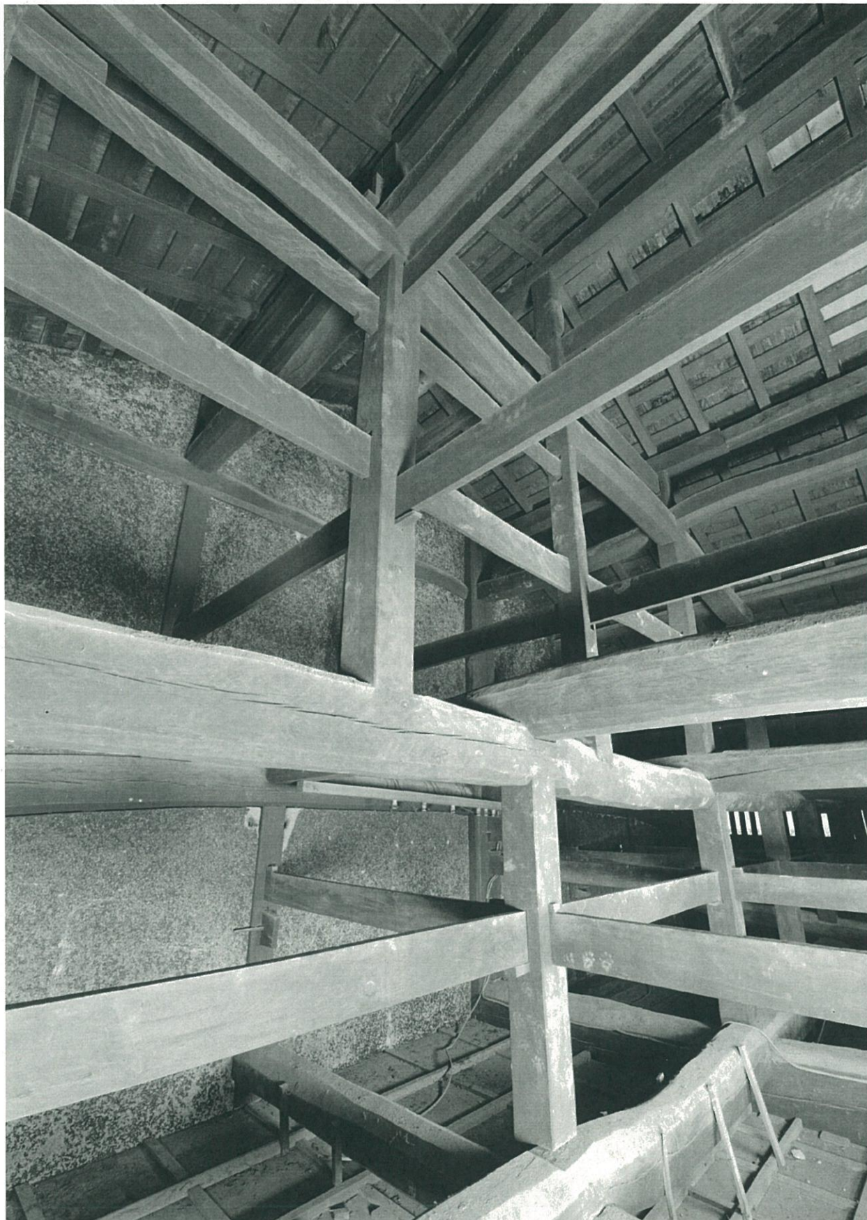
5. 旧山崎家住宅主屋土間側小屋組（南東より）
