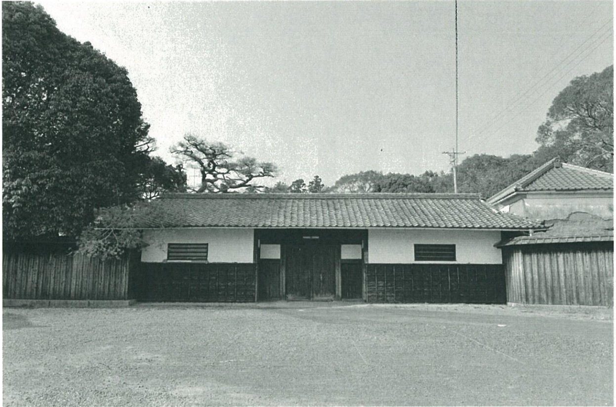
8. 旧山崎家住宅長屋門（南より）
