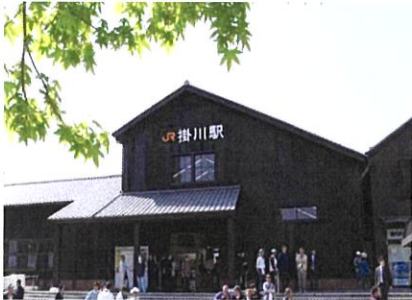
新幹線駅唯一の木造駅舎の保存
