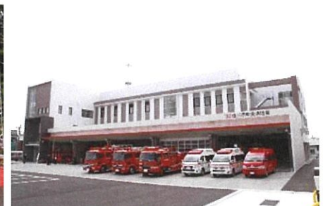
消防本部・中央消防署新庁舎を整備
