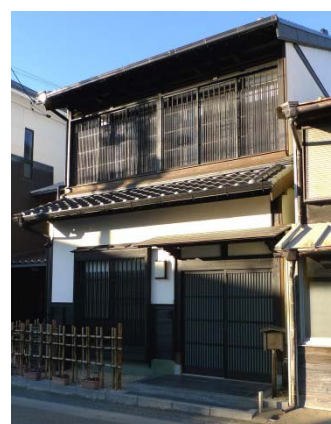
格子窓の設置例（横須賀地区）
