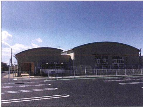
駐車場整備・外壁改修
