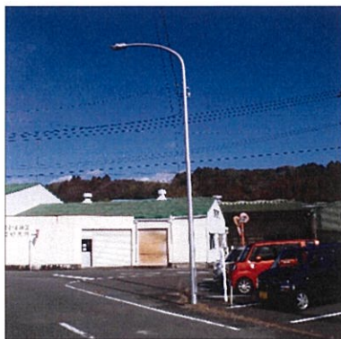
道路照明灯の玉切れ
