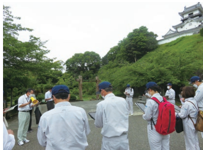
掛川城天守閣修復景観整備工事の現場
