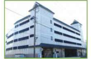
大手門駐車場外観
