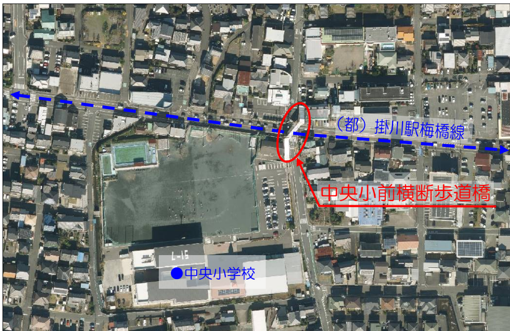
図 4.7 横断歩道橋 位置状況（中央小前横断歩道橋）
