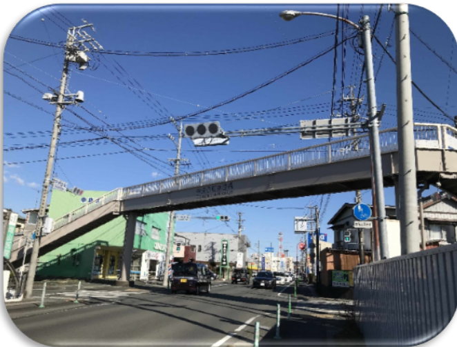
鋼橋（中央小前横断歩道橋 市道掛川駅梅橋線）
