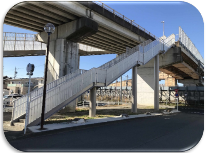
鋼橋（杉谷成滝歩道橋 市道杉谷成滝線）
