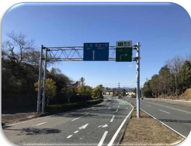
鋼製（道路標識 31 市道市立病院通り線）
