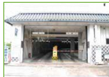
大手門駐車場入口
