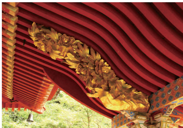
手扶（たばさみ：向拝柱の内側に、屋根の垂木勾配に沿って入れられた化粧板）には、金色の八重牡丹と葉が立体的に浮き彫りされている。
