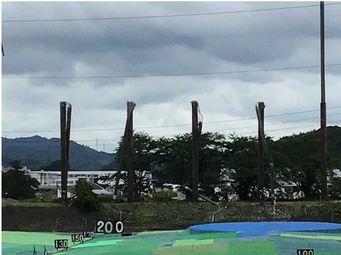
36 ゴルフ練習場支柱転倒
