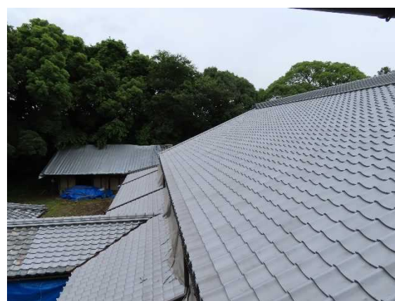
右 令和5年 瓦の葺き替えが完了した主屋屋根
