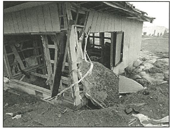
【決壊付近】被災した家屋
