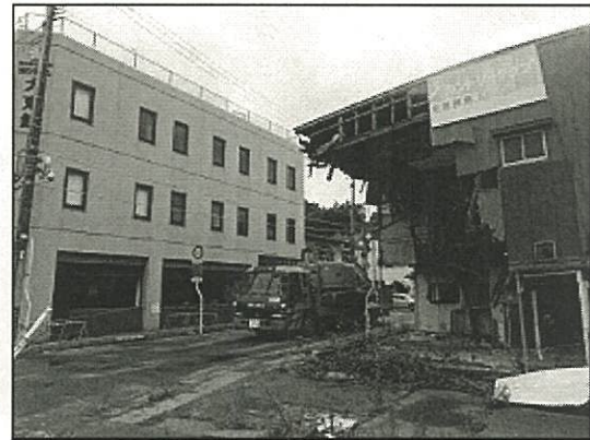
【富岡駅前】工事車両が入り、解体作業を始めている
