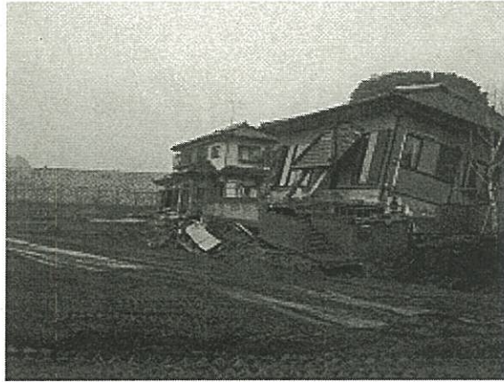
常総市鬼怒川決壊現場
