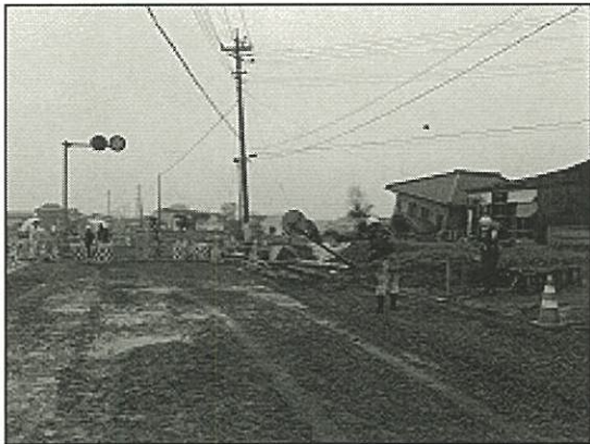
【決壊場所付近】破壊された道路の復旧作業
