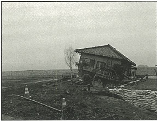
【決壊付近】被災した家屋と復旧した堤防(奥)
