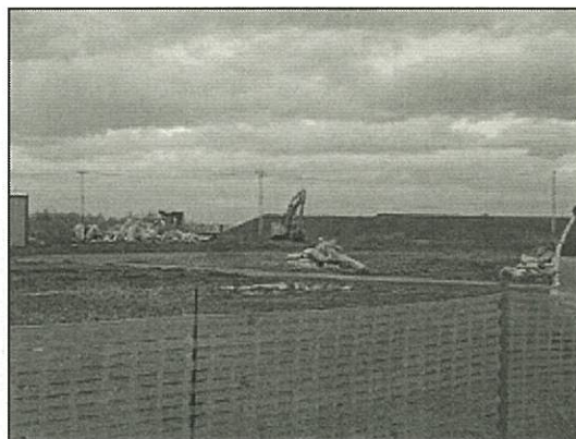
【関上港付近】住宅用地の盛土工事
