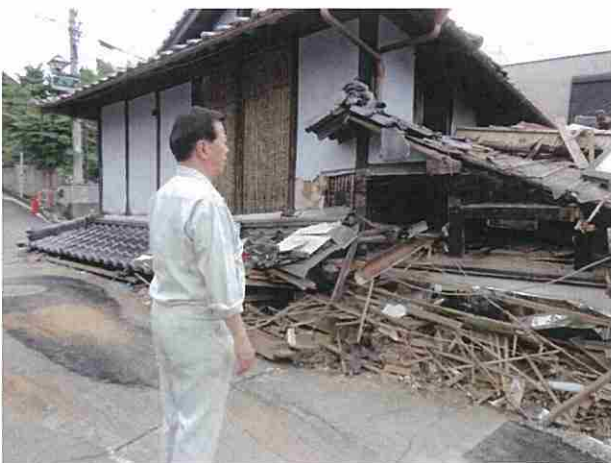
益城町での倒壊家屋視察
