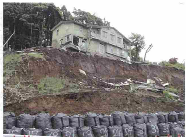
南阿蘇村での土砂崩れを視察
