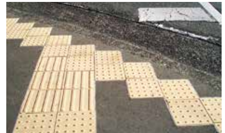
点字ブロック
