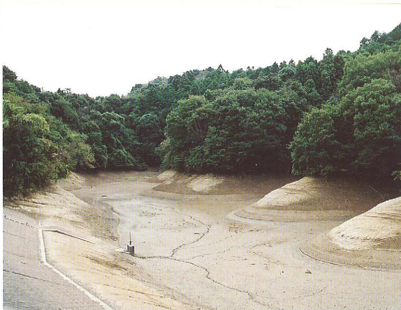
ため池は谷が入り組んでいる地形を生かしてつくられました。(亀の甲池 中央小学区)
