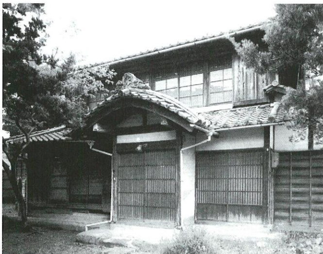
現在は大日本報徳社内にある冀北学舎の建物
