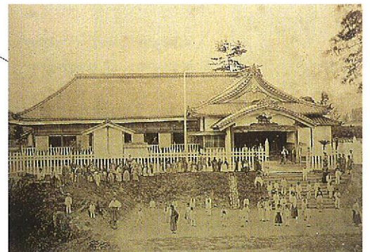
掛川学校(掛川城内、写真は明治6年ごろ) 掛川城御殿です。
