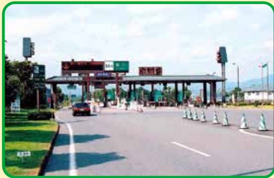
東名高速道路 掛川インターチェンジができる (平成5年)
