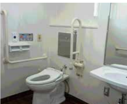
中央小新校舎のバリアフリートイレ
