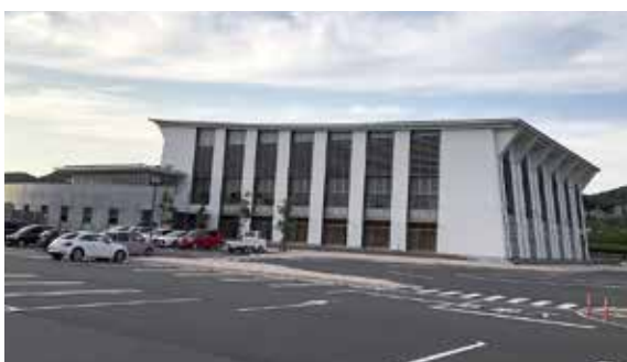
広域避難所に指定されている指定管理施設の一つ 南体育館「し〜すぽ」
