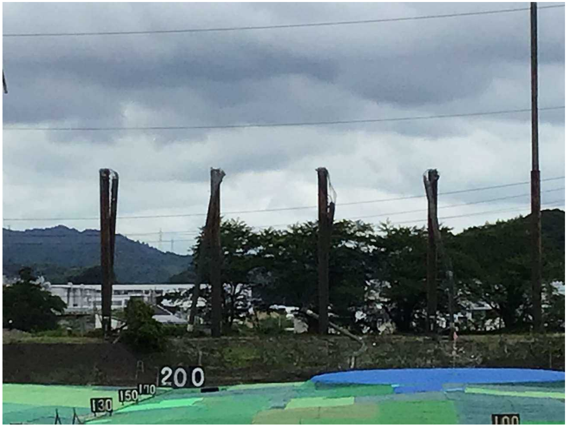
ゴルフ練習場支柱転倒
