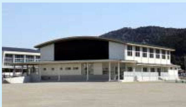
▲完成した原野谷中学校屋内運動場
