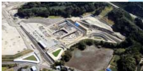
▲建設が進む中東遠総合医療センター
