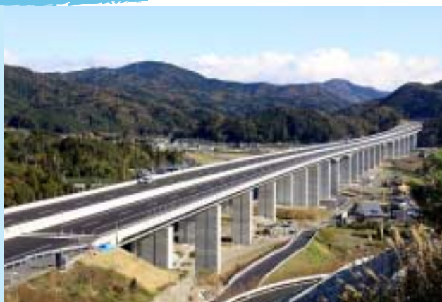
▲平成24年初夏に開通する新東名高速道路 (宮ヶ島高架橋、寺島原里地内)
