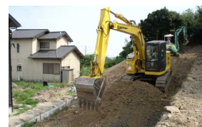
④ 大型重機で進入路建設
