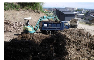
④ ダンプ積み込み 木材は地元区民の新利用
