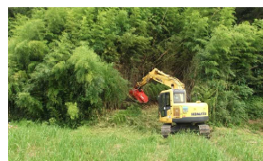
③ 広大な面積のため、重機も活用
