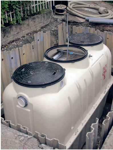
合併浄化槽の設置
