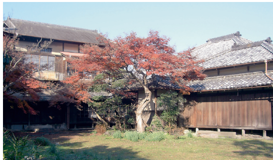
平成20年度まで修復工事が行われる「竹の丸」
