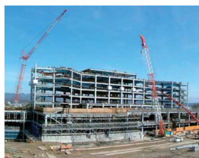
新病院建設工事は順調に進んでいます
