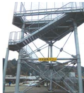
津波避難タワー
