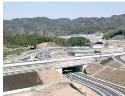
完成した森掛川インターチェンジ
