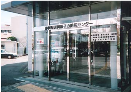
浜岡原子力防災センター
