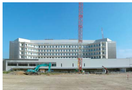
建設が進む中東遠総合医療センター
