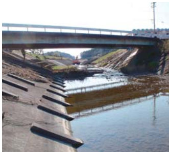
長寿命化が計画されている川久保橋(下土方地区)
