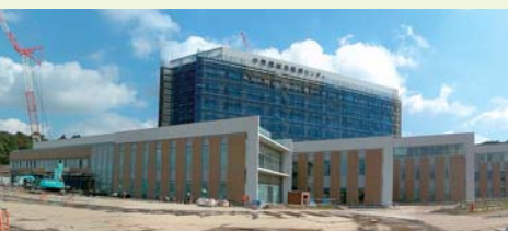
建設中の「中東遠総合医療センター」
