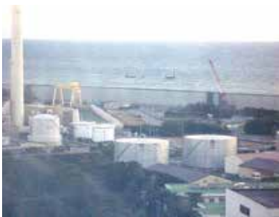
浜岡原発防潮堤工事
