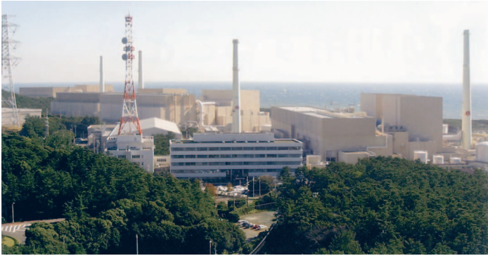
浜岡原子力発電所
