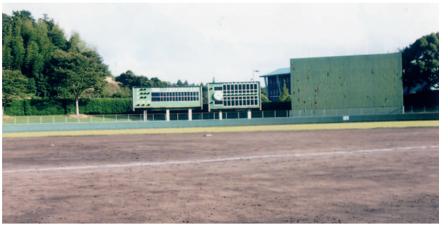
夜間の照明設備を望む「掛川球場」
