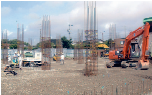
建設が始まった「大須賀交流センター」
