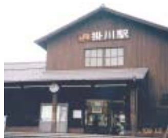
特徴ある外観をそのまま残すべき（掛川駅北口）
