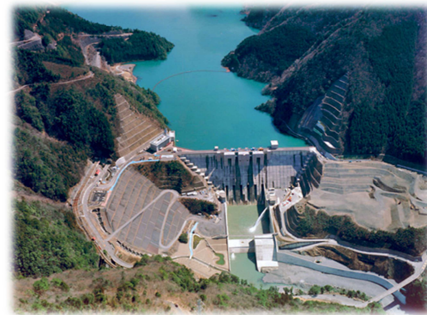
掛川市の水源『長島ダム』
