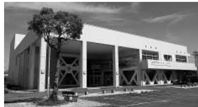
大須賀中央公民館リニューアル(平成21年8月27日開館)
