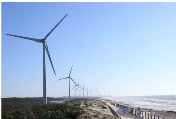
海岸線地域に立ち並ぶ風力発電所
