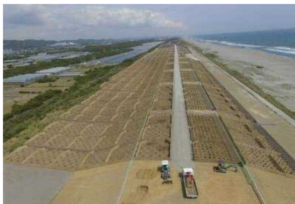
工事が進む掛川潮騒の杜
