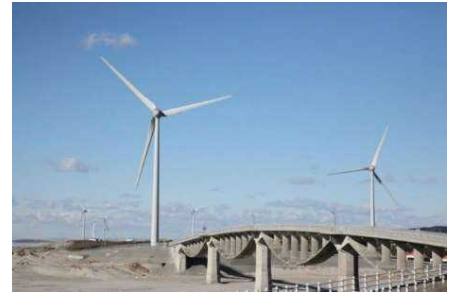
潮騒橋付近の風力発電所
