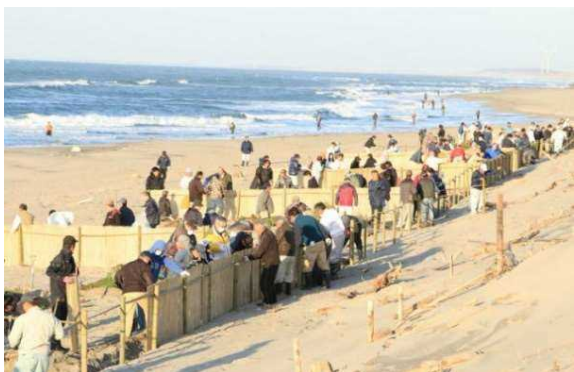
砂浜を守る堆砂垣の設置
