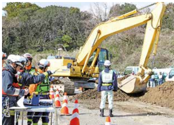
▲重機を使って緊急車両用通路を確保する建設業者ら
