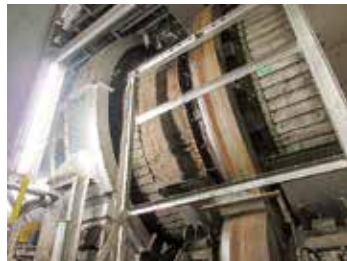
▲今回亀裂が発見された熱分解ドラム「キルン」
