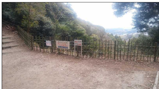
危険箇所の柵補修(完了)
