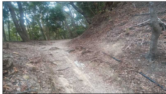
遊歩道の補修(完了)
