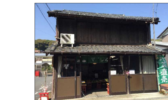
古民家を改修した店舗
