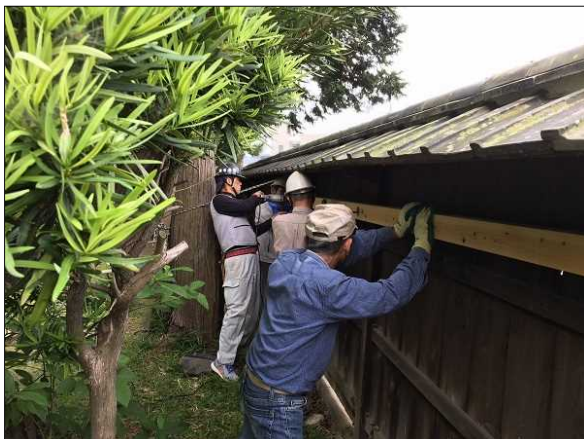
市民との協働で、塀の傾きを補修
