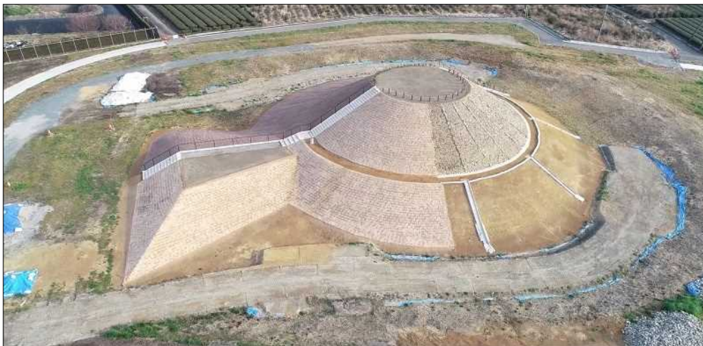
国史跡和田岡古墳群 吉岡大塚古墳整備工事
