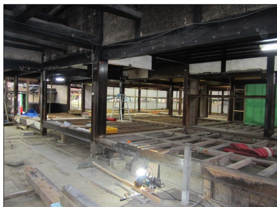
工事内部の様子
