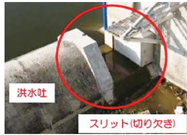
ため池の貯水機能を高める洪水吐スリット
