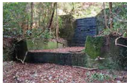
土砂が流出しないよう設置された治山ダム
