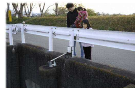
河川水位観測システム 10
