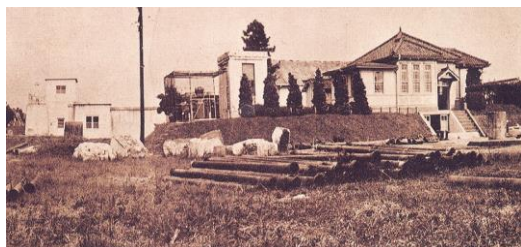
創設当時の十九首浄水場
