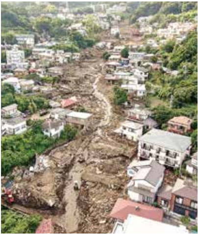
▲ドローンで撮影した伊豆山土砂災害の様子（静岡市消防局提供）
