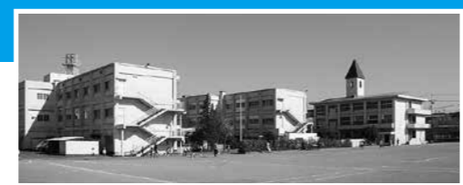
中央小学校（校舎西側グラウンドから） 北・中央の校舎棟は、昭和39年の同校創立時から使用されてきました。グラウンド南側に新校舎の建設を予定しています。
