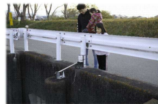
河川水位観測システム 19
