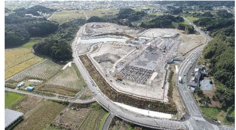
整備が進む「大坂・土方工業用地」
