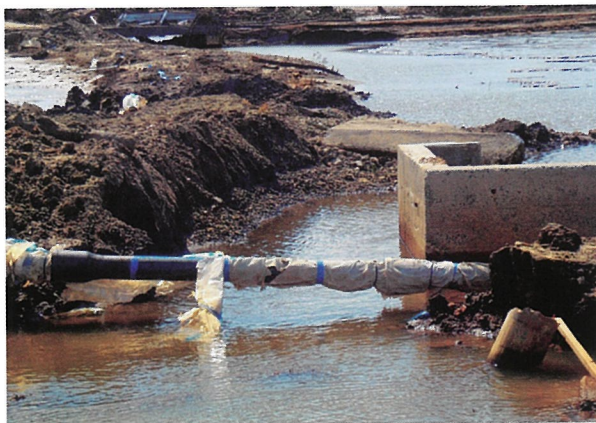
津波・地震による被害がなかった耐震管路（平成 23 年：東日本大震災） 宮城県仙台市水道局 提供
