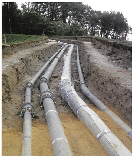
配水管等の布設工事 福島県白河市水道部 提供
