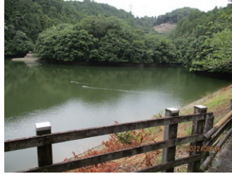
農業用水と防災ダムの機能を持つ 桜木池
