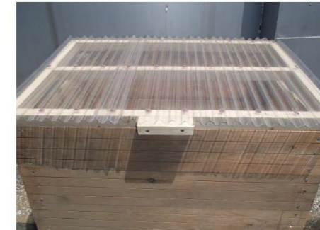
フタ用材料(1)角材④をネジで固定
