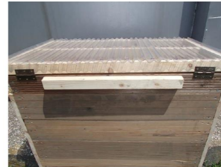
本体用材料(2)角材⑤をネジで固定
