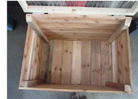
本体用材料(1)板④をネジで固定。
