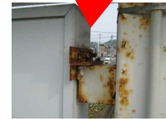
←取付金具のサビや腐食。ボルトやビス等が欠落していたら緊急の対応が必要。放置すると看板が落下する恐れも。
