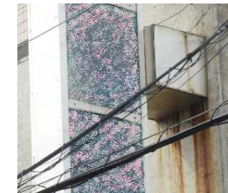
←ブラケット下に汚ダレが見られると、内部の取付金具にサビや腐食の可能性もある。
