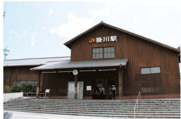
耐震化工事前の掛川駅木造駅舎
