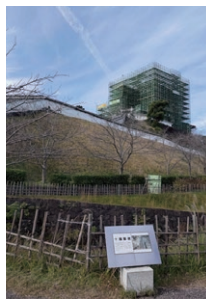
工事中の掛川城
